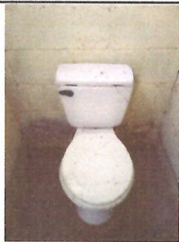
Foto 5: Sustitución de sanitarios lavables, accesorios y conexiones.
