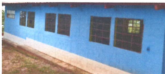
Foto 3: Sustitución de ventanas; sistema de apertura: Corredizas, Perfiles color blanco estándar, Material del marco: PVC Material de la ventana: Vidrio, sellado perimetral
