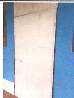
Foto 2: Mantenimiento a puerta metálica existente retiro de óxido, suciedad y pintura deteriorada; incluye cepillado, lijado, aplicación de pintura y reparación de marcos metálicos.
